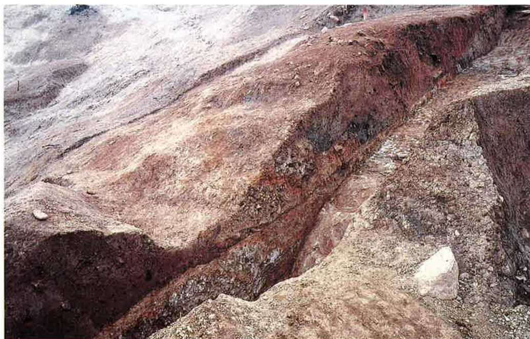
第3環壕地滑り状況（土層断面写真）
