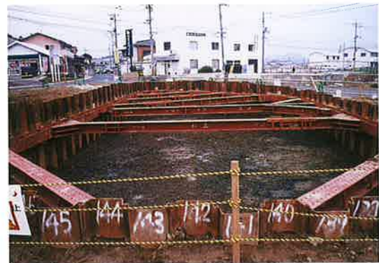
矢板を打って、「さあ作業開始！」
