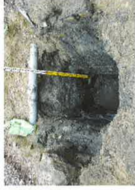
重機による掘込み 東側から
